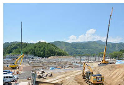
大槌高等学校のグラウンドに平成 28 年 9 月の開校を目指して工事が進む大槌学園小中一貫校の建設現場
