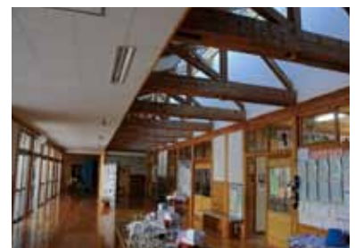
地場産の木材を用いてつくられた温かみのある校舎。廊下は広く、オープンスペースや中庭なども備えています
