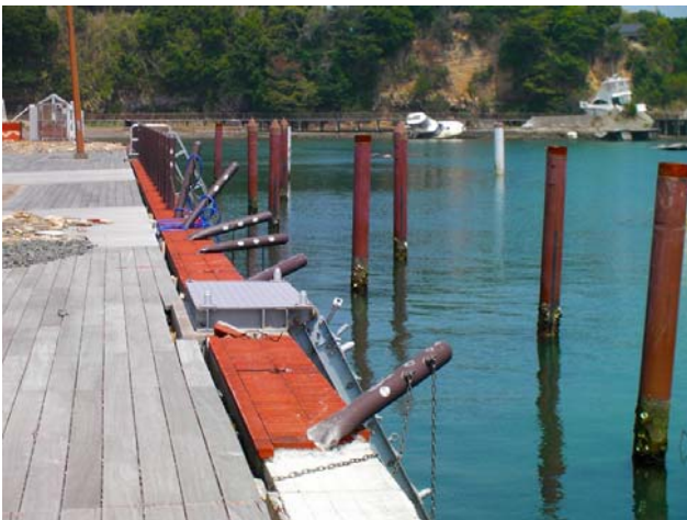
引き波でへし折られたマリーナの支柱
